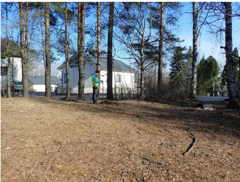
Kuva 6. Koekuopan kaivamista alueen länsiosaan.
